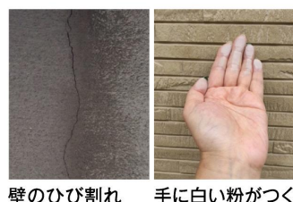
壁のひび割れ 手に白い粉がつく
