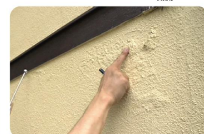
外壁の浮きやハガレをチェック。
